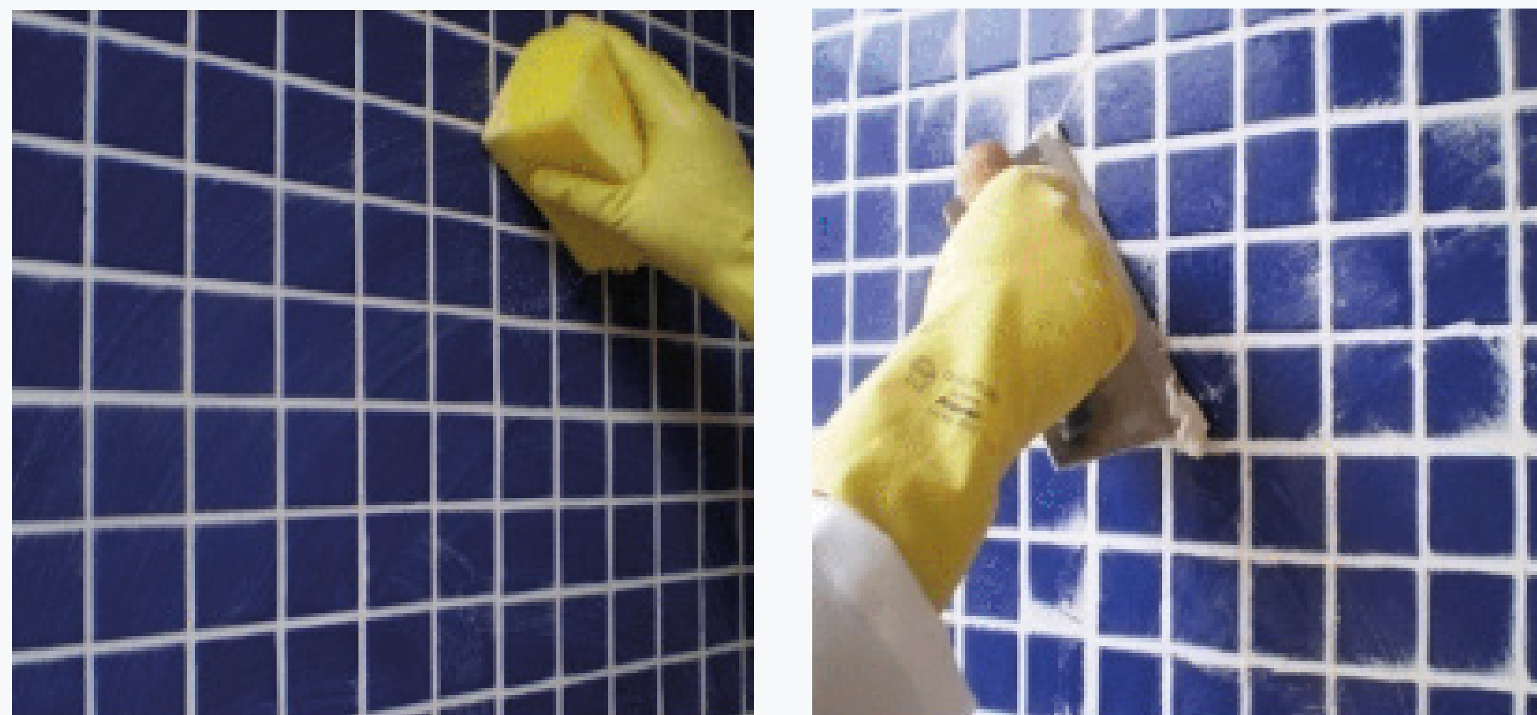
Aplicação do rejunte e processo de retirada dos excessos com o auxílio de uma esponja
