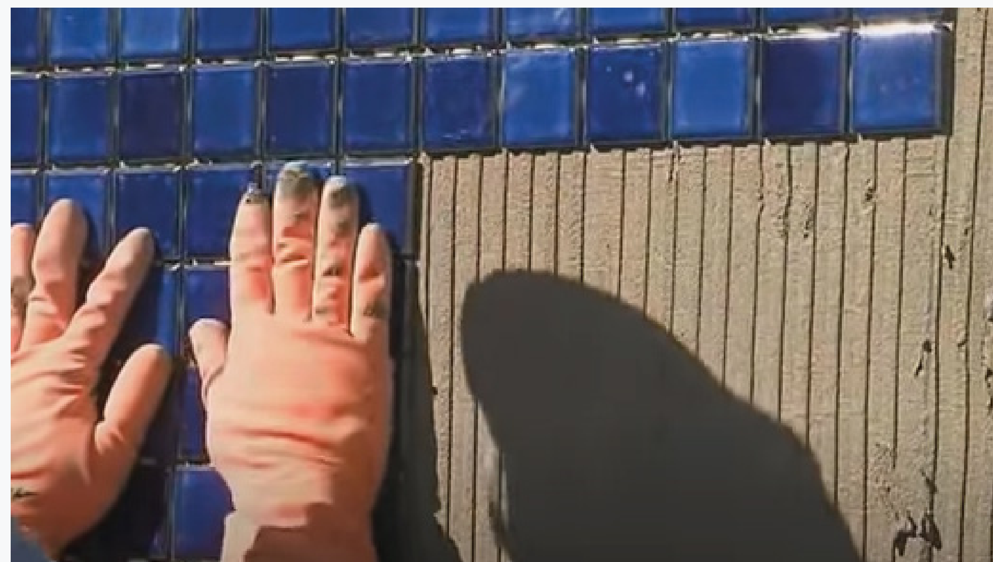
Aplicação do revestimento sobre a parede preparada
